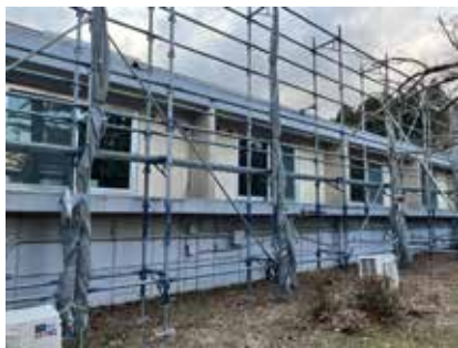
▲足場が組まれた外回り。屋上の防水シートの張替えや外壁塗装はこれから。
