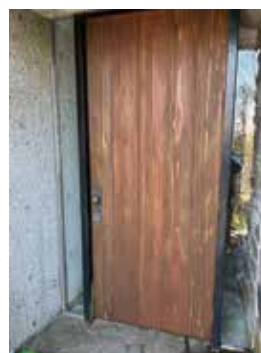
扉は大工さんの手作りで、金物などは貴重品のため以前の物を再利用したりしています。
