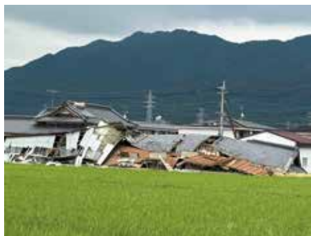
▲倒壊した家屋（八代市内）
